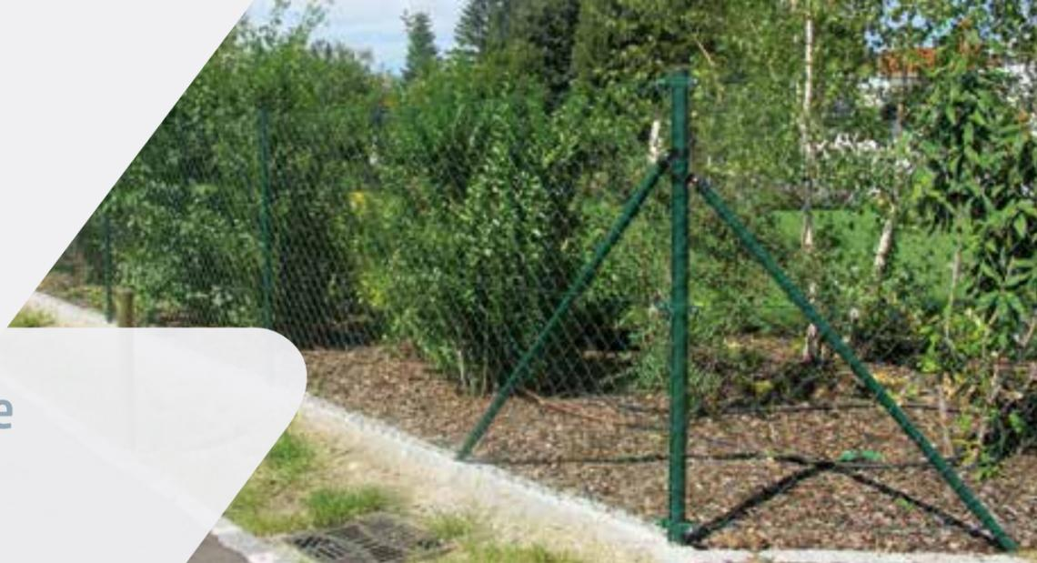
Aus Stahlrohrprofilen inkl. Kappen, End- bzw. Eck- oder Zwischen-Laschen und 3-4 Drahthalter und Drahtspanner. Diese sind von Brix bereits montagefreundlich auf die gewählte Geflechthöhe voreingestellt. Die Brix Pfähle sind so konzipiert, dass die Draht-Spanner/Halter bei Bedarf in der Höhe verschoben werden können.
